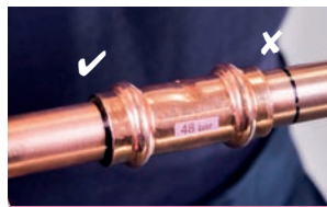
10. Führen Sie das Rohr komplett in den Fitting
