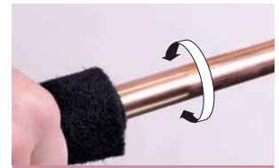
4. Reinigen Sie das Ende des Rohres
