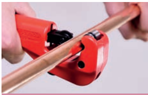
1. Kürzen Sie das Kupferrohr
