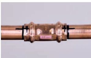
13. Markieren Sie die Verbindung
